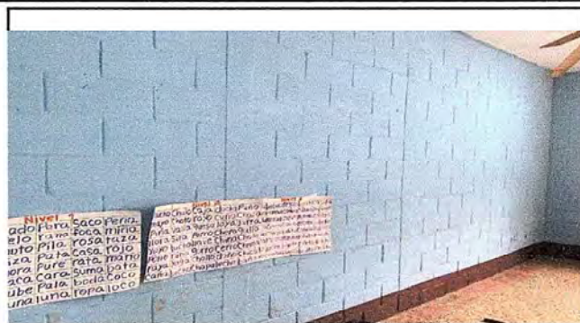
Foto 2: PINTURA EN AULAS DE TODO EL ESTABLECIMIENTO.
