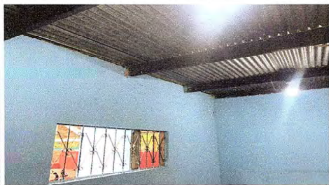
Foto 3: INSTALACIÓN ELÉCTRICA EN EXCELENTE ESTADO
