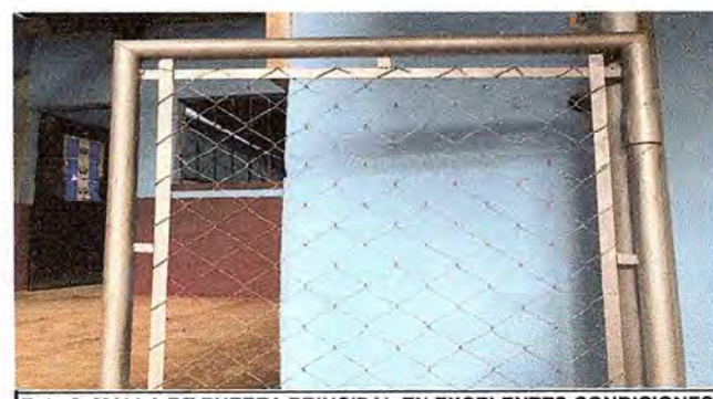
Foto 6: MALLA DE PUERTA PRINCIPAL EN EXCELENTES CONDICIONES.
