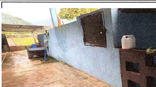
Foto 1: PINTURA EN PAREDES DE LOS SANITARIOS.
