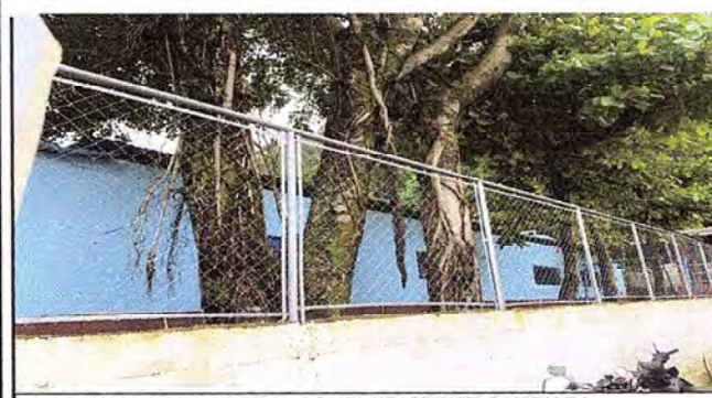
Foto 5: MALLA PERIMETRAL COMPLETAMENTE CAMBIADA.
